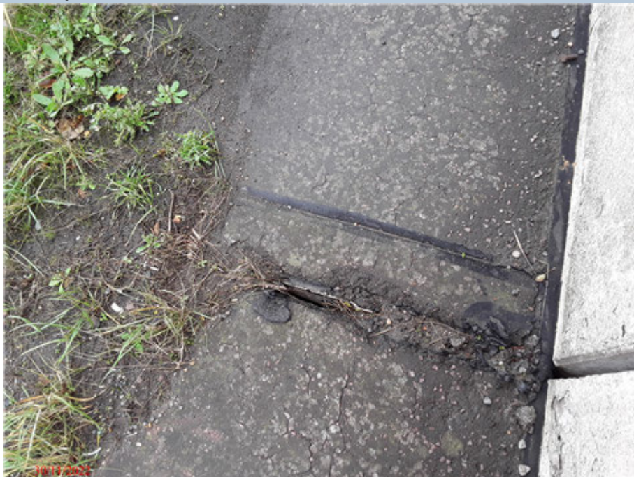
Span 1 - East Footway APJ APJ south edge open.
